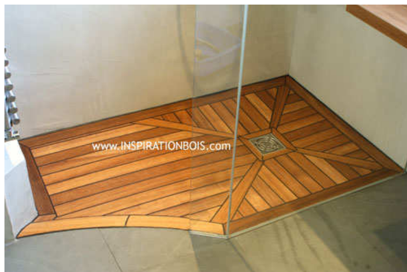
4 pentes - Entrée en courbe concave et décroché en pointe
