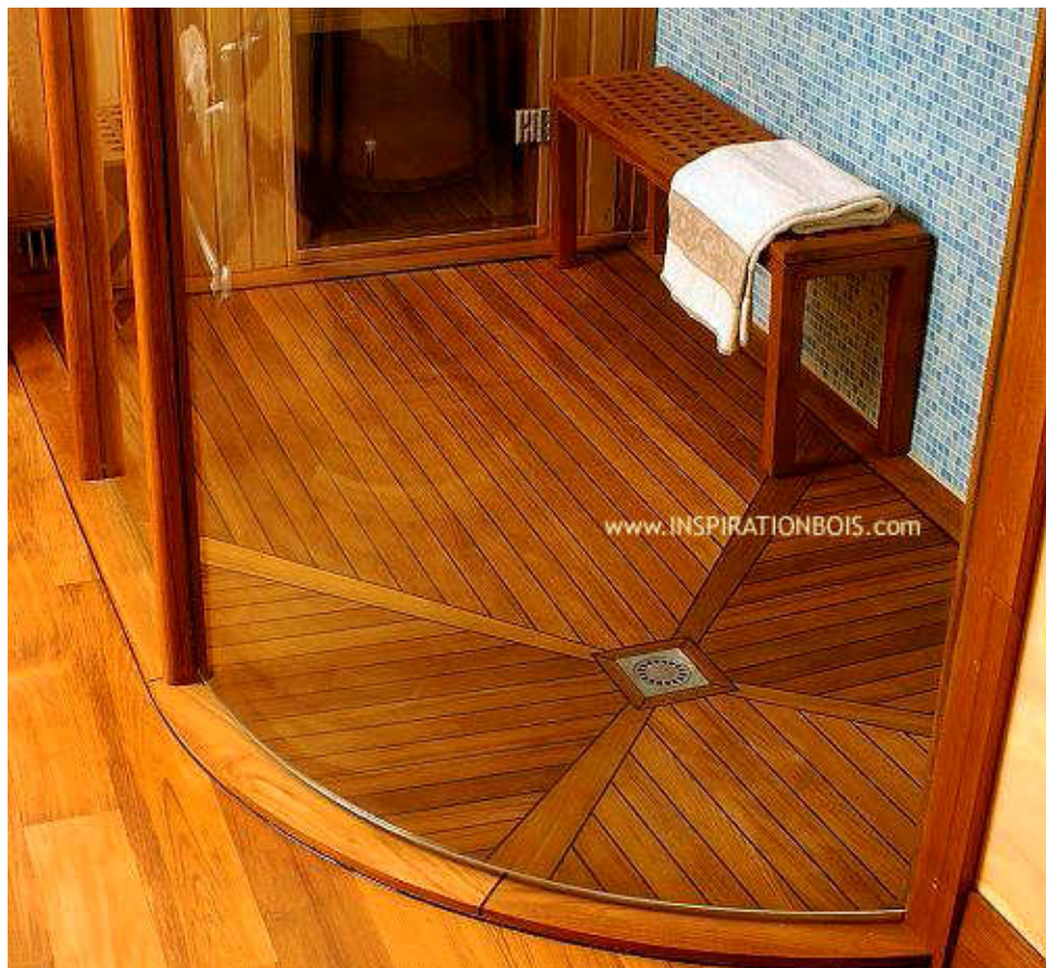
Sortie de sauna - salle de sport privée - Receveur à 4 pentes A quart de rond, pare-douche en verre bombé réalisé sur mesure et montants Teck
