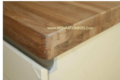
Épaissement de chant avant et de retour sur plan lamellé-collé
