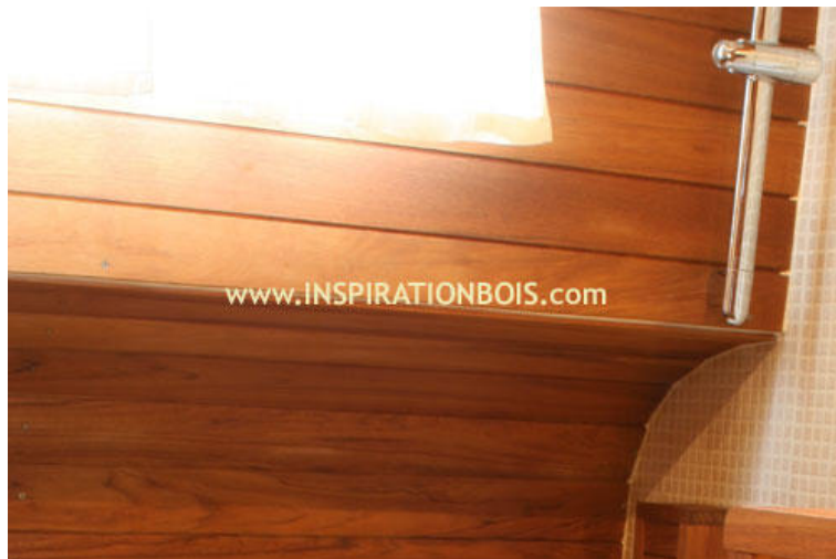
Vaigrage en Teck posé aux murs d'une salle de bain de bateau
